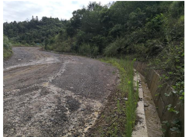
通往破碎站道路排水沟
