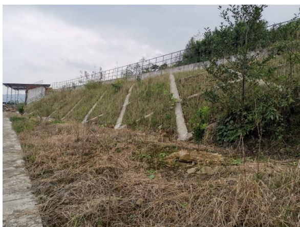
框格护坡植草措施
