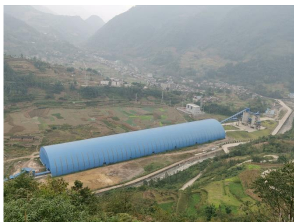
堆料场区全貌
