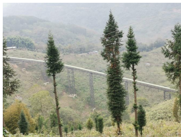
输送管线沿线迹地恢复措施
