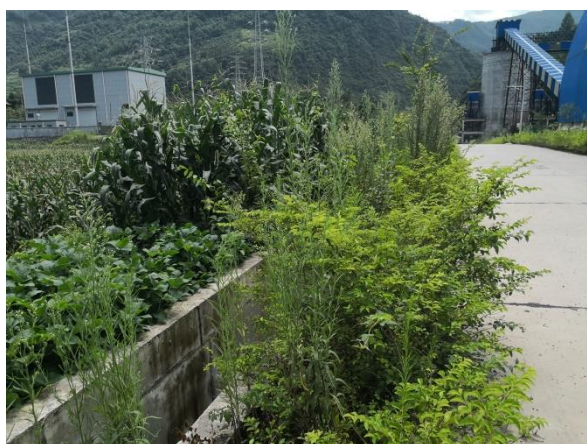
堆料场区排水沟
