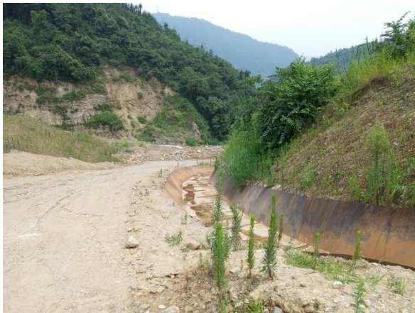
通往排土场道路排水沟
