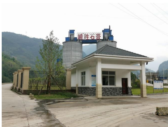
堆料场区入口
