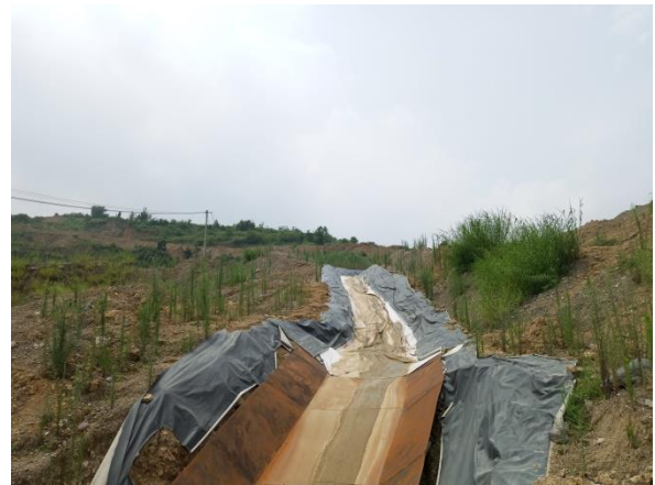
通往排土场道路排水沟
