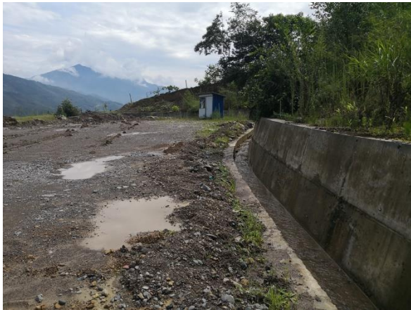
通往破碎站道路排水沟
