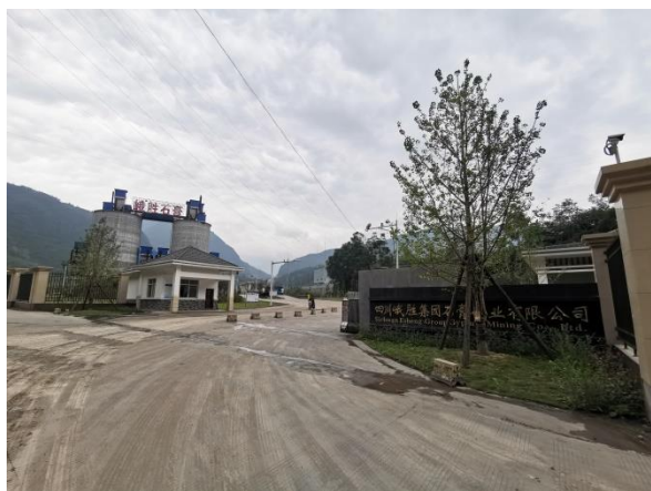
堆料场区全貌
