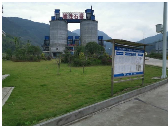
堆料场区全貌
