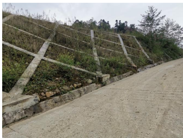
框格护坡植草措施
