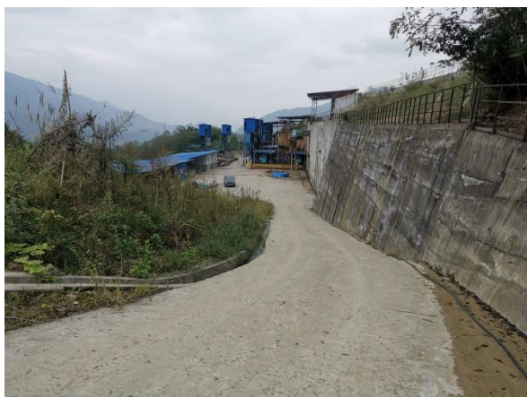
挡墙及排水沟措施
